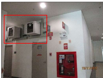
รูปที่ 2-53 เครื่องกำเนิดไฟฟ้าสำรอง และระบบไฟ แสงสว่างฉุกเฉินแบบใช้แบตเตอรี่ (1)
