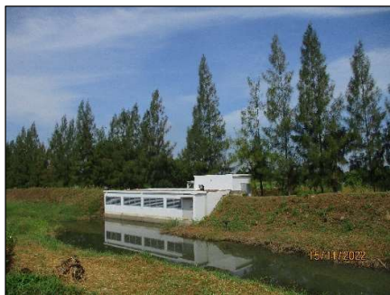
รูปที่ 2-13 ประตุน้ำด้านทิศเหนือที่ระบาย ลงสู่คลองสี่ เพื่อหน่วงน้ำและป้องกันน้ำจากภายนอก ไหลเข้าสู่โครงการ
