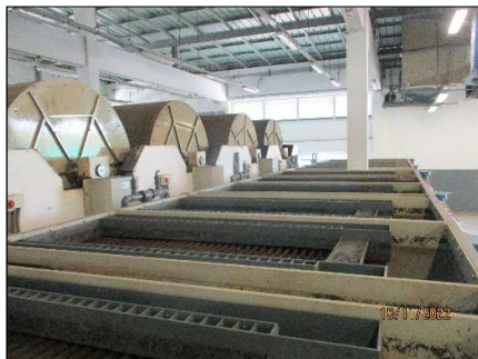
รูปที่ 2-5 ระบบบำบัดน้ำเสียรวม แบบ RBC
