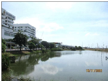
รูปที่ 2-11 บ่อหน่วงน้ำด้านทิศตะวันตกใกล้กับอาคาร โรงพยาบาล ขนาดความจุ 10,551 ลบ.ม.
