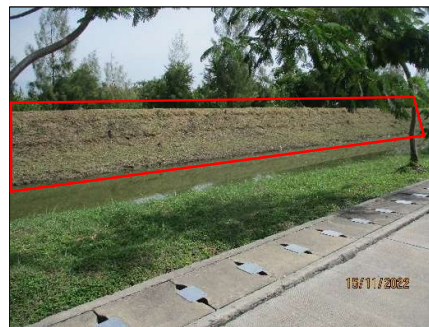
รูปที่ 2-14 คันดินล้อมรอบพื้นที่โครงการขนานกับราง ระบายน้ำภายในเพื่อป้องกันน้ำไหลเข้าสู่อาคารและพื้นที่โครงการ
