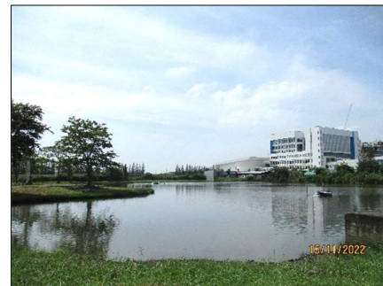
รูปที่ 2-12 บ่อหน่วงน้ำด้านทิศตะวันตกใกล้กับอาคาร นันทนาการ ขนาดความจุ 13,304 ลบ.ม.
